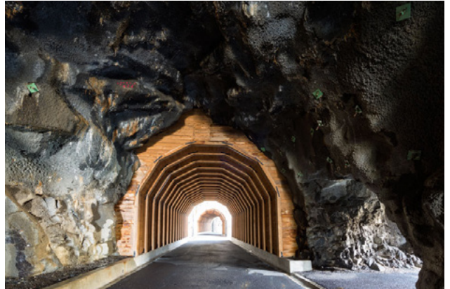
La restauración de los túneles Mosier Twin Tunnels fue un hito importante en el esfuerzo por reconstruir la histórica autopista de Troutdale a The Dalles.
